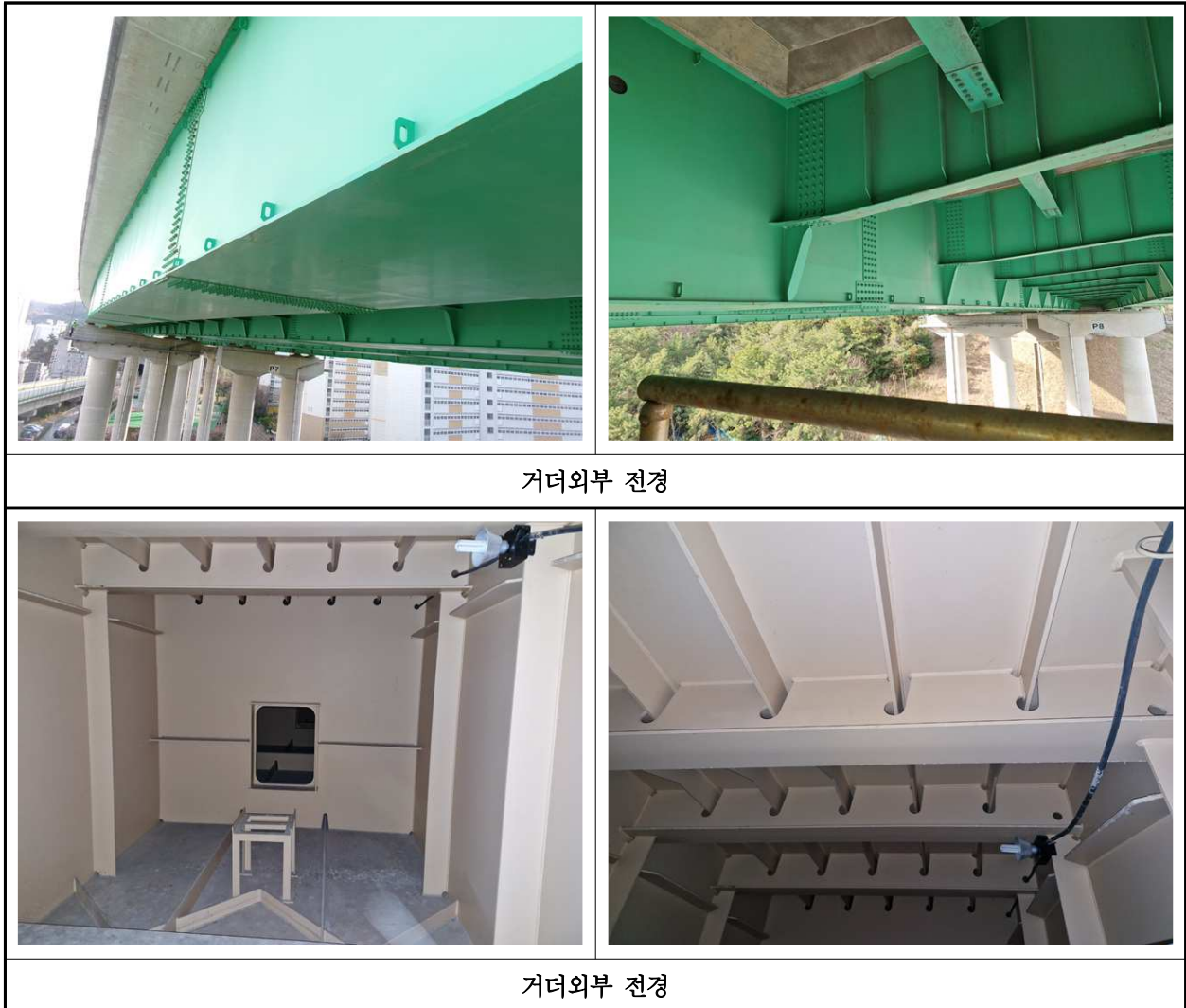
【사진 4.3.4】 거더 전경
