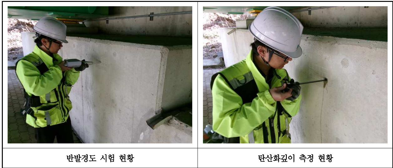
【사진 4.4.1】 콘크리트 내구성조사 현황
