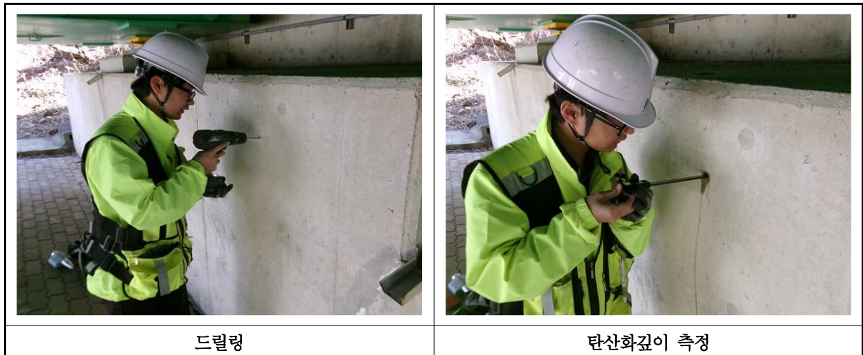
【사진 4.4.3】 탄산화 깊이 측정 현장사진
