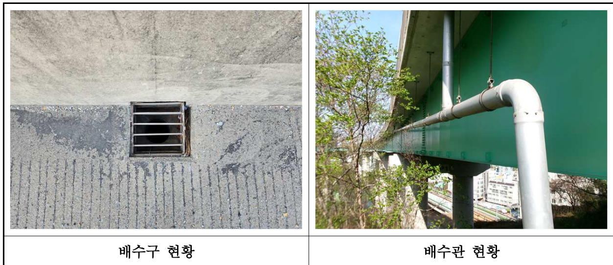
【사진 4.3.22】 배수시설 전경
