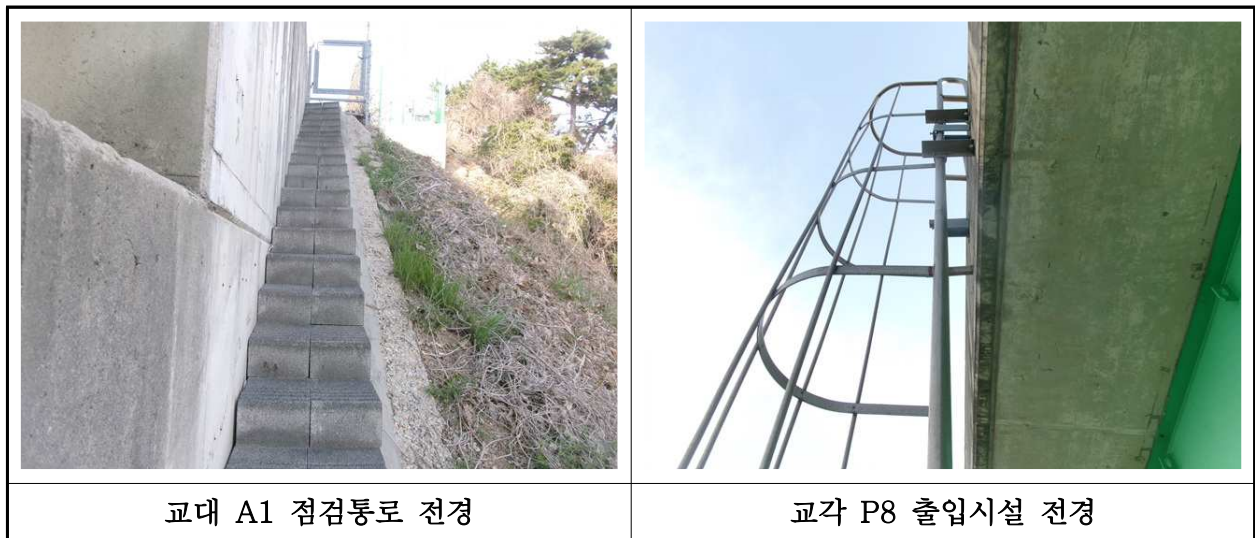
【사진 4.3.26】 교량 점검시설 전경
