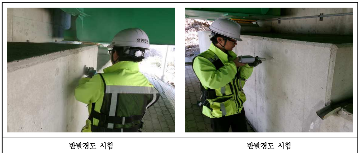
【사진 4.4.2】 반발경도시험 현장사진
