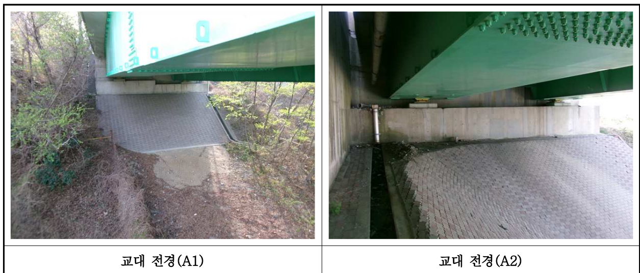
【사진 4.3.8】 교대 전경
