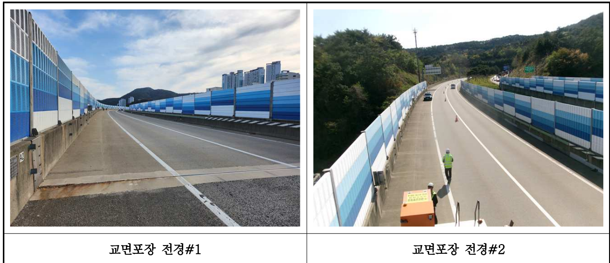
【사진 4.3.20】 교면포장 전경
