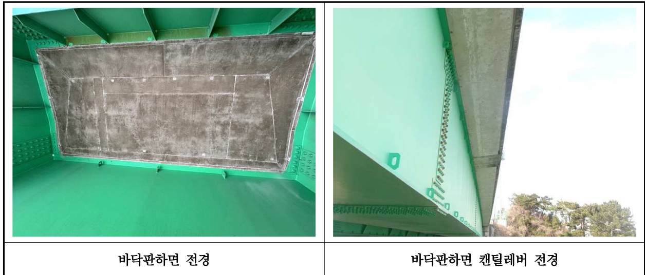
【사진 4.3.2】 바닥판하면 전경
